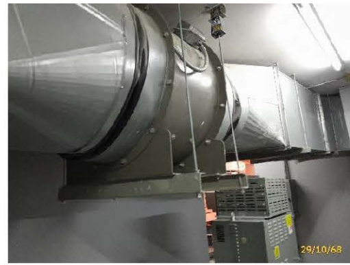
ระบบอัดอากาศบริเวณโรงลิฟต์ดับเพลิง
