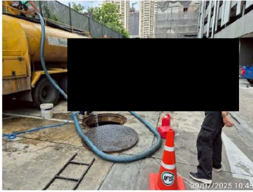
การสูบน้ำ และตะกอนระบบบำบัดน้ำเสีย
