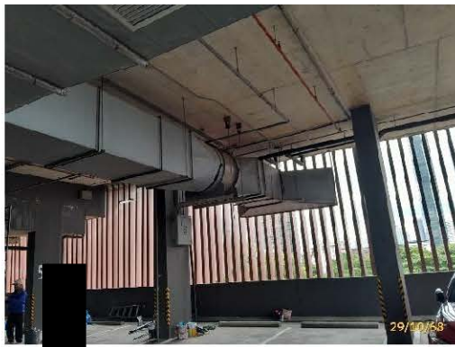
ระบบอัดอากาศบริเวณโรงลิฟต์ดับเพลิง
