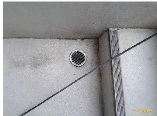
ตะแกรงครอบตามรูท่อระบายน้ำ
