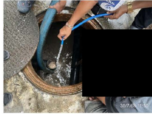
การสูบน้ำ และตะกอนระบบบำบัดน้ำเสีย
